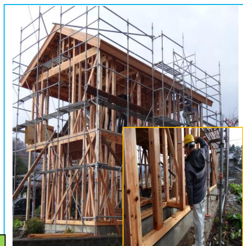
【新築住宅建築中】
