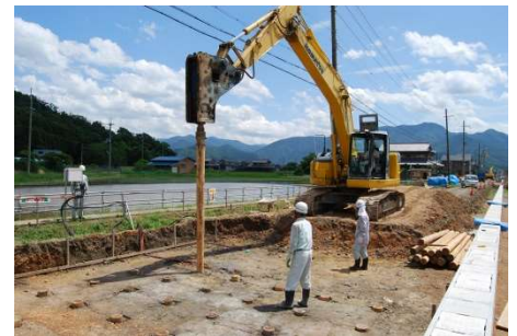
道路路体を対象とした地盤補 強のための丸太杭打設見学会 平成23年6月21日、小浜市
