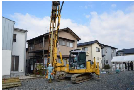
住宅基礎を対象とした地盤補 強のための丸太杭打設見学会 平成25年3月6日、坂井市
