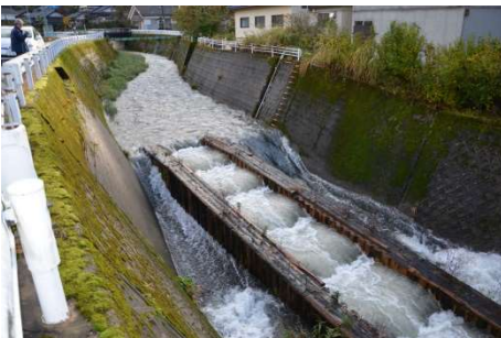
平成24年度見学会 平成24年11月15日、永平寺町 魚道および木工沈床
