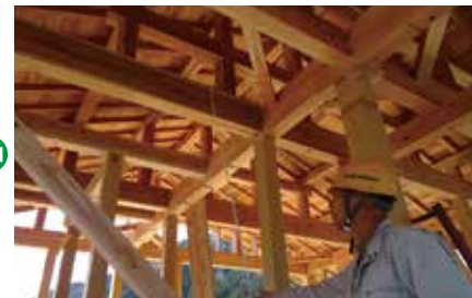
横架材の使用確認
