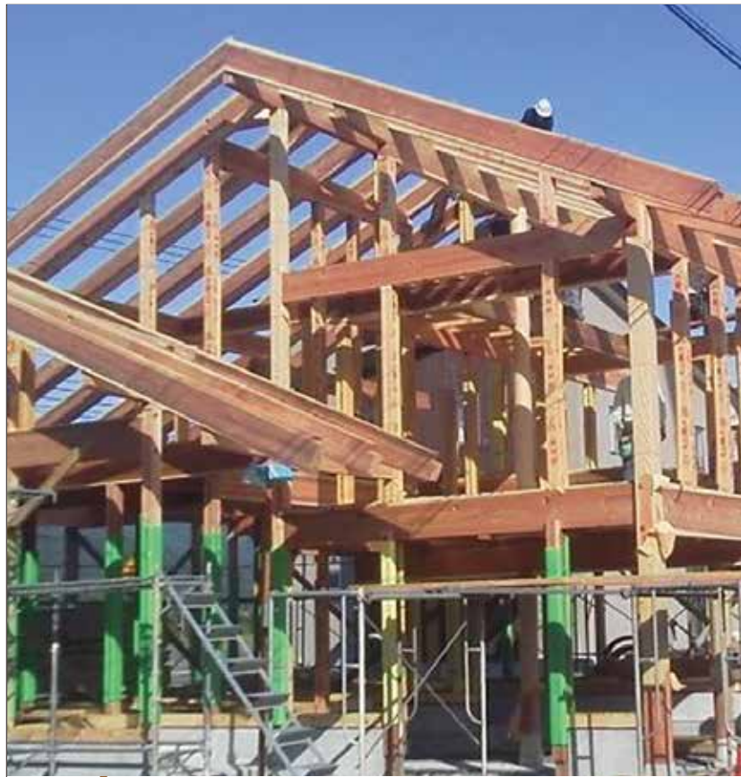
木造軸組工法（建築中）
