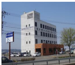
福井県木材会館 駐車場 福井市羽水3丁目110番地 電話 0776(35)5663
