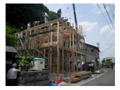
新築住宅 (建前中)
